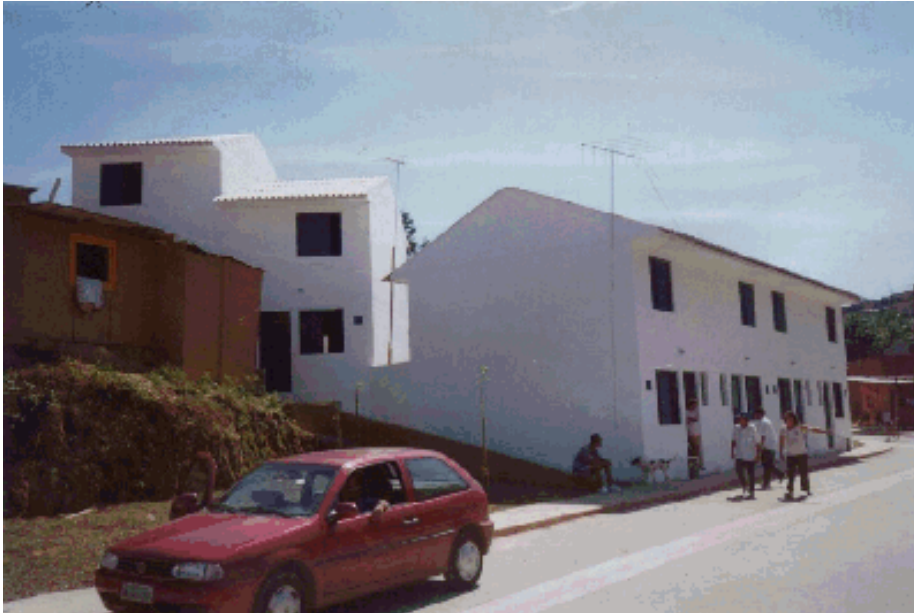
Figura 3: Unidade habitacional construída para reassentamento na favela pela Prefeitura de São Paulo.
