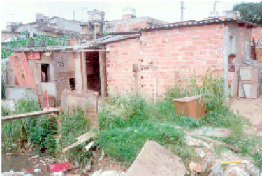
Figura 1: Unidade habitacional indicada para remoção.
